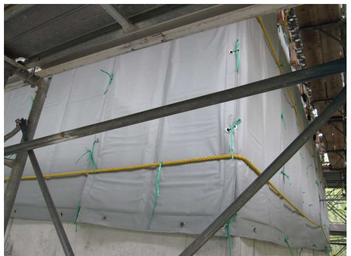
● 高規格幹線道路の橋梁工事のコンクリート打設
