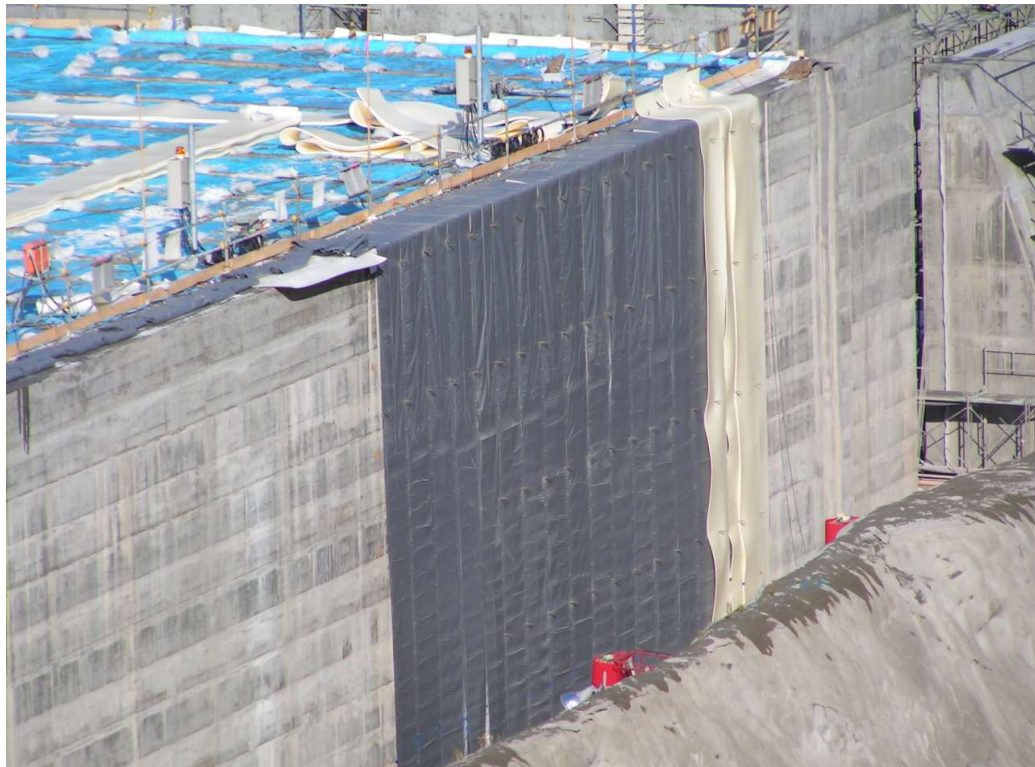
● ダム堤体 寒中コンクリート垂直面の施工事例
