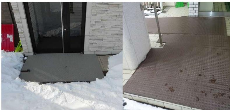
マンションの入口、エントランスに融雪マットを設置すると、面倒な除雪作業をしなくても、融雪マットが雪を融かしてくれます。
